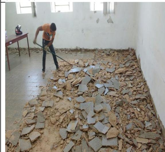
Remoção de piso danificado das salas de aula do Campus Altamira. Serviços de manutenção abrangendo os banheiros, estruturas de telhado, reparo nas instalações hidrosanitárias, troca de lâmpadas e luminárias.
