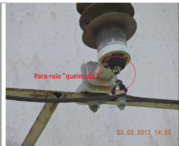
Para-raio da fase B na saída da cabine de medição danificado -- RELATÓRIO TÉCNICO 011/2017 -- DINF/PROAD/IFPA
