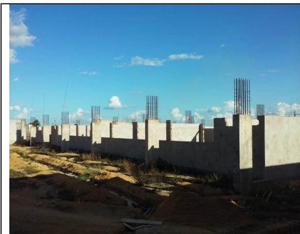
Vista do bloco pedagógico com alvenaria do primeiro pavimento executado e rebocado.
