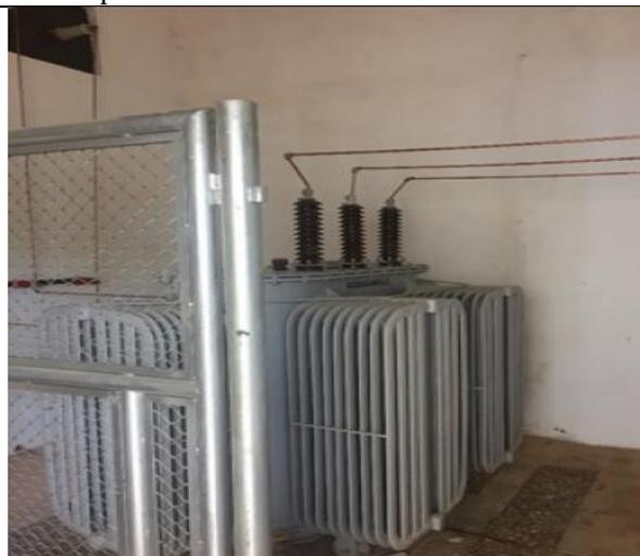
Fornecimento e Montagem de subestação abrigada com capacidade de 750kVA, 34.500/13.800V
