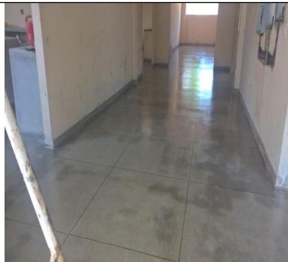
Em 2017, a DINF Acompanhou e fiscalizou a Reforma e Adaptação do Bloco de Laboratórios do Campus Conceição do Araguaia - Piso de alta resistência pronto.
