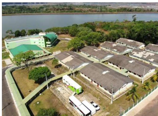
Reforma dos antigos alojamentos
