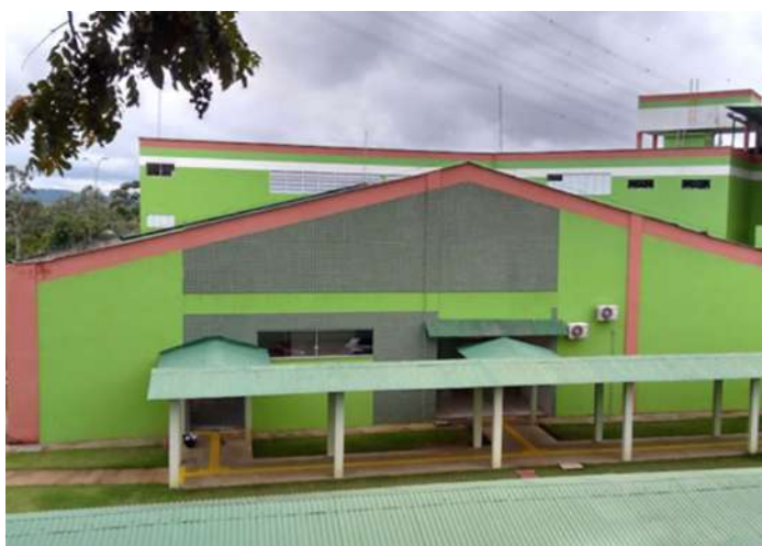
Bloco pedagógico e urbanização
