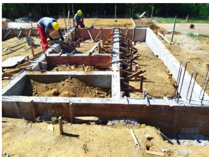
Construção do Bloco Pedagógico
