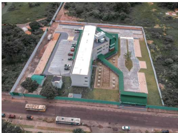
Bloco pedagógico e urbanização
