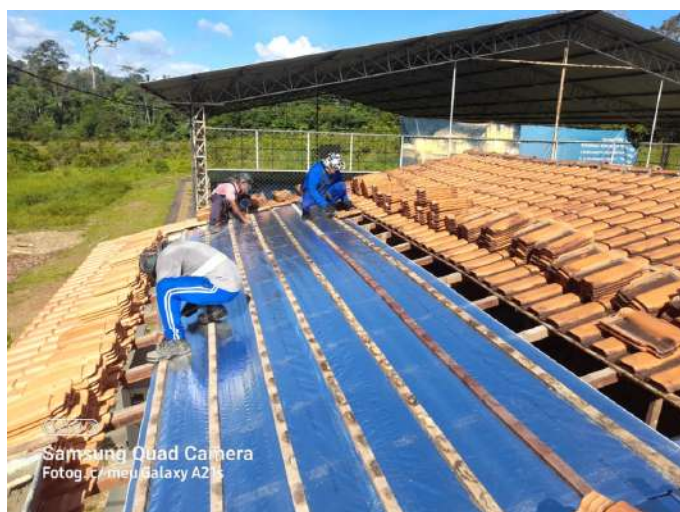
Reforma do telhado
