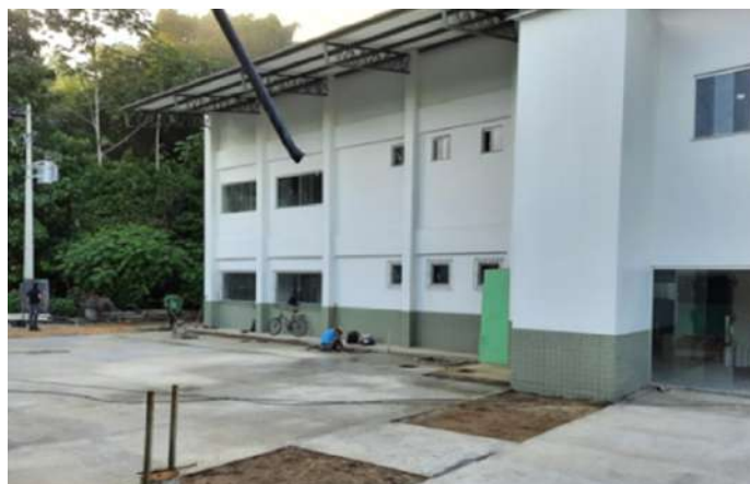
Construção do bloco pedagógico e de pesquisa
