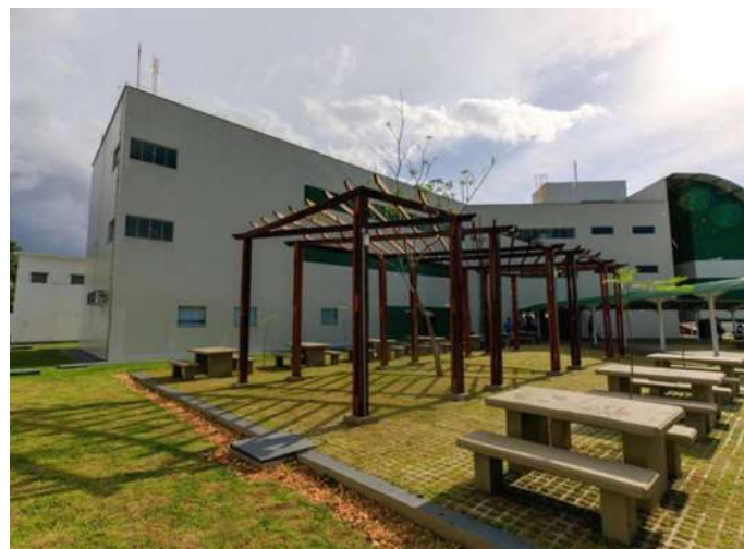
Bloco pedagógico e urbanização
