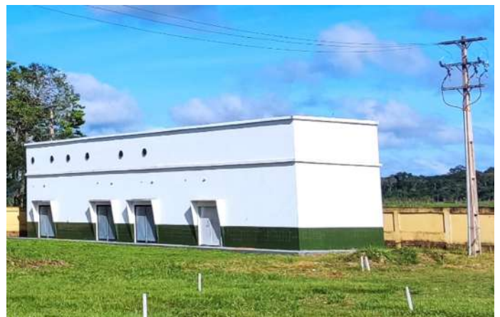
Subestação e rede elétrica
