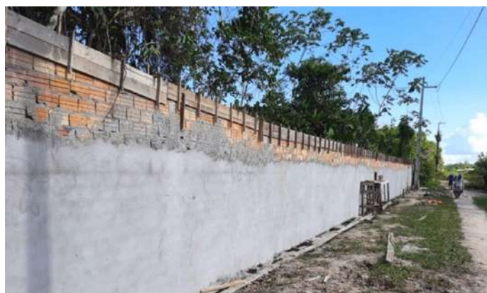
Construção do muro
