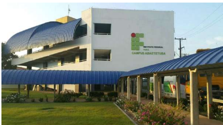
Reestruturação do bloco pedagógico
