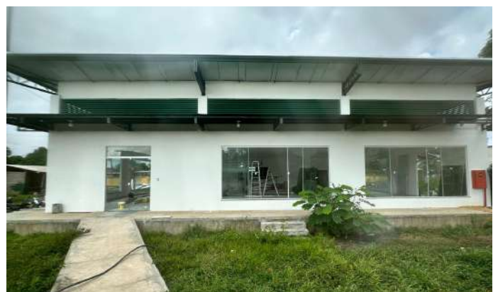
Construção do Refeitório
