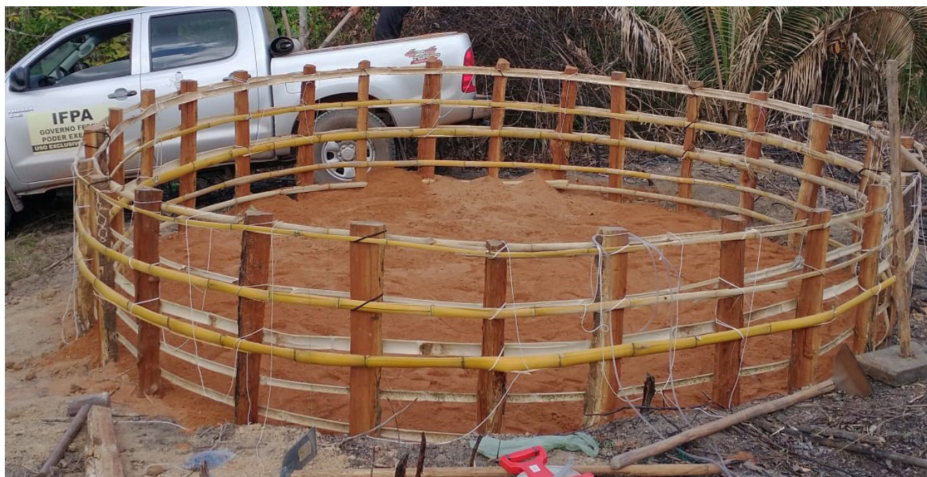
Figura 18 - Amarração das estacas de madeiras com ripas de bambu.
